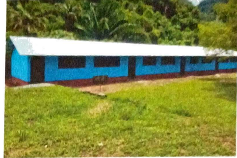
Foto 2: Se observa la instalación completa de la estructura metálica del centro educativo.
